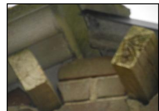
Figuur 7 ontbreken van open nok.
