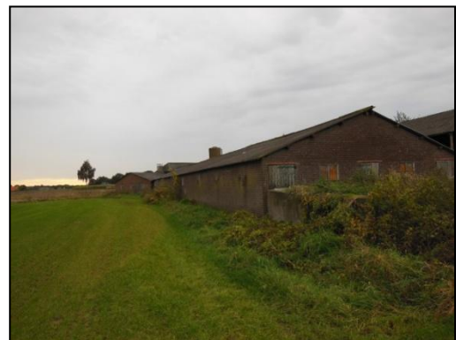
Figuur 4 Te slopen varkensschuur.
