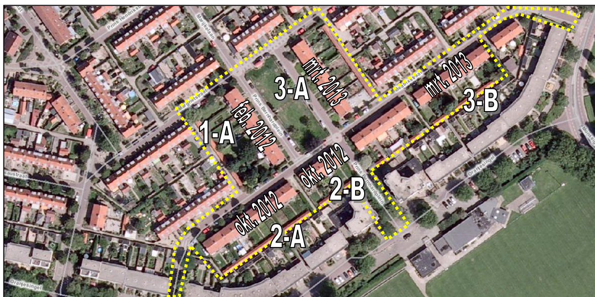
Figuur 2 Luchtfoto onderzoekslocatie (bron: Atlas Groen Gelderland) met sloop fase en sloopdatum
