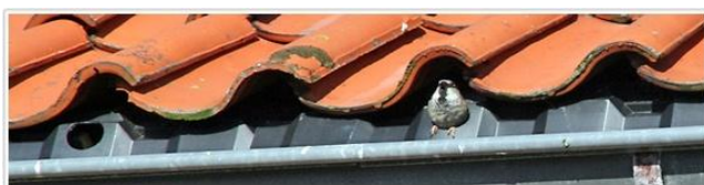
Figuur 6: vooraanzicht vogelvide onder eerste rij dakpannen (bron: Vogelbescherming)
