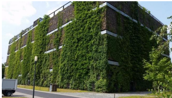
Figuur 26. Parkeergarage High Tech Campus (Eindhoven)
