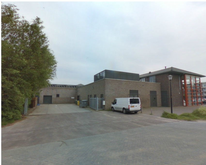
Figuur 3: Plus en Lidl aan de achterzijde, de uitbreiding aan de Zijderupsvlinderlaan (noord-oost gevel)
