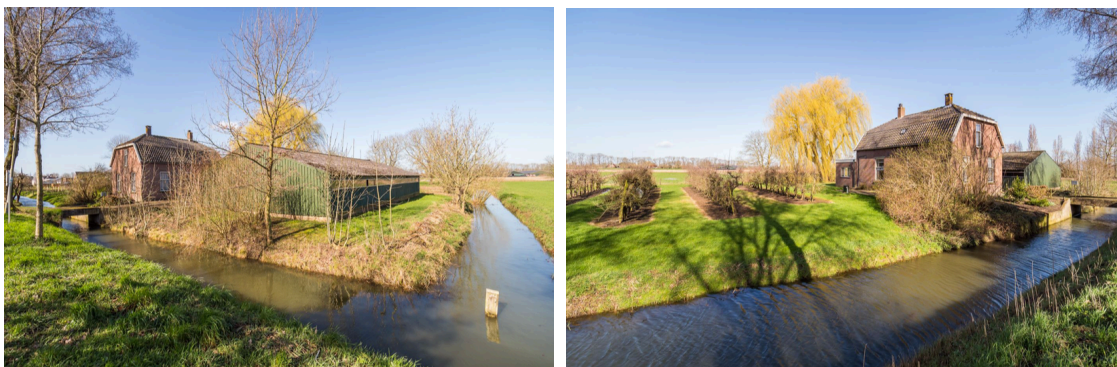
Fig. 3.2 Projectlocatie Lange Dreef 6, met woning en rechts daarvan (in groen) schuur
