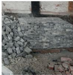
Metselwerkplint: Licht grijze gerecupereerde ijselsteentjes
