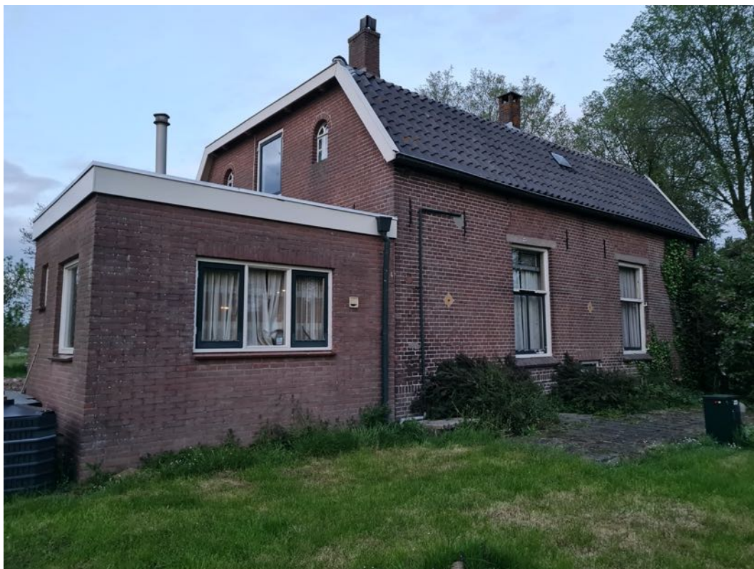
Foto 1: Westzijde van het voormalig woonhuis aan de Lange Dreef 6.
