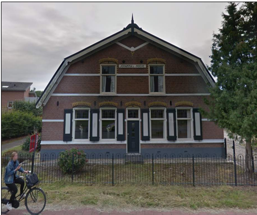
Figuur 2.7: Huidige staat van de voorgevel van de Johanna's Hoeve (bron: Google Maps).
