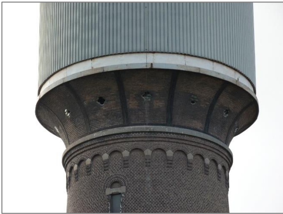
Afbeelding 1.3 | Ramen bovenzijde watertoren.
