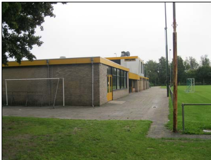
Foto 1: Het te slopen sportcomplex met potentiële vaste verblijfplaatsen voor vleermuizen.
