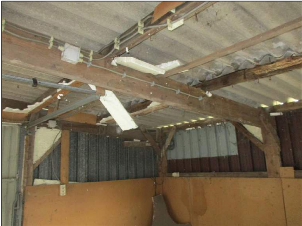
Figuur 3 Binnenzijde van de schuur op de planlocatie.
