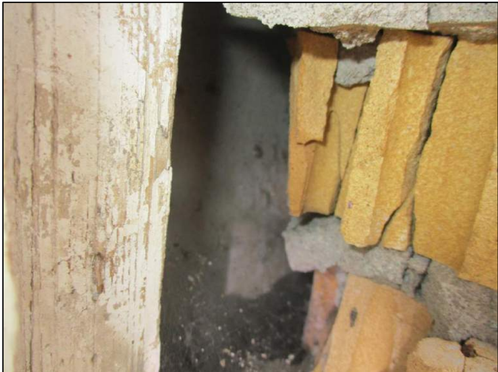
Figuur 4 Detail ongeïsoleerde spouwmuur van het woonhuis op de planlocatie.
