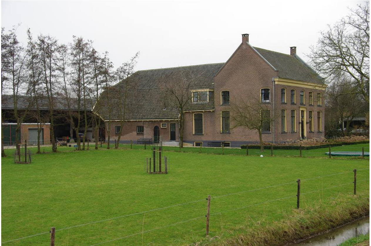
Boerderij 'Huize De Sleutel' gezien vanuit het noorden met op de achtergrond de kapschuur
