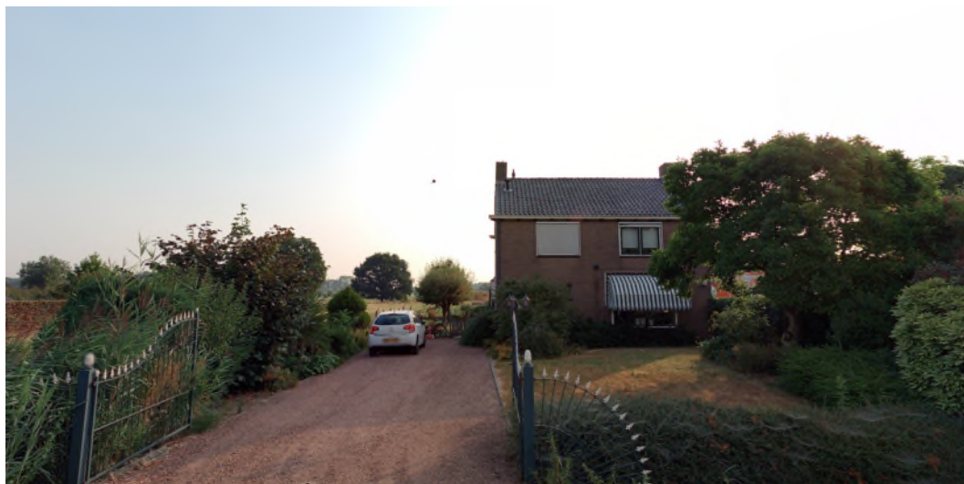
Bestaande bebouwing Honddijk 4 (bron: Globespotter 2018)
