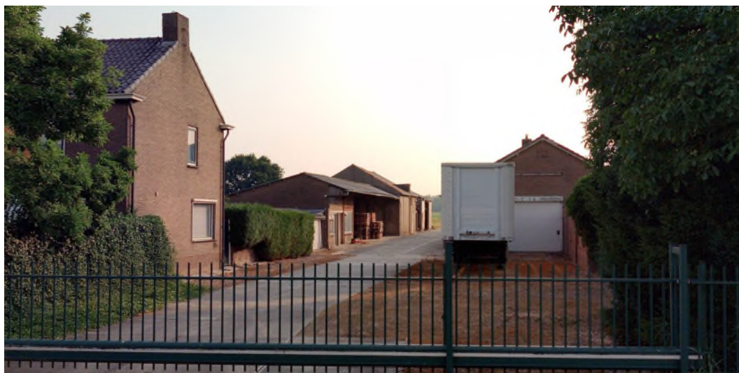
Links de woning Honddijk 4 en rechts de aanwezige bedrijfsbebouwing (bron: Globespotter 2018)
