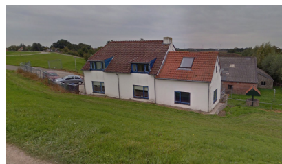
De dijkwoning evenwijdig aan de dijk met aanbouw en waterput.
