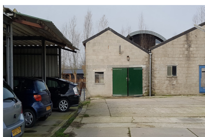
Op het erf staan diverse schuren. Door het materiaalgebruik zoals lichtgekleurde celbeton en damwanden zijn de schuren opvallend aanwezig in het agrarische landschap.
