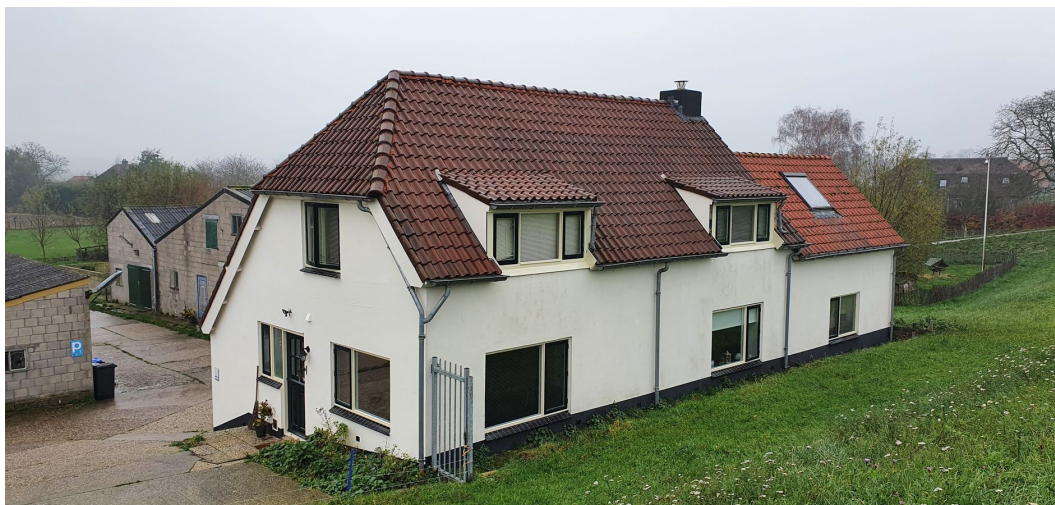
Het woonhuis (3) gelegen aan de dijk. Foto: K. de Vries | Ecoresult B.V.
