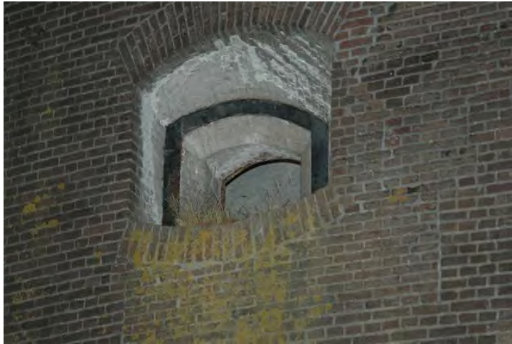
Figuur 11: De door vleermuizen gebruikte toegang tot de toren, het open raam in kamer 23.
