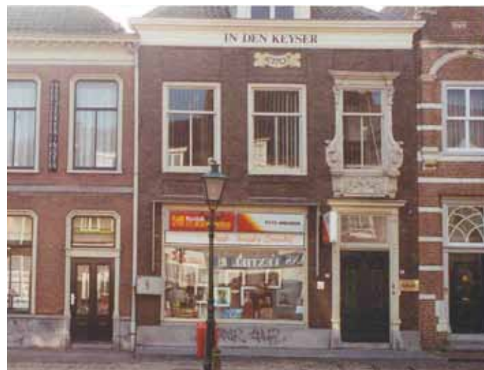
Doorbreking historische gevelindeling: te groot glasvlak
