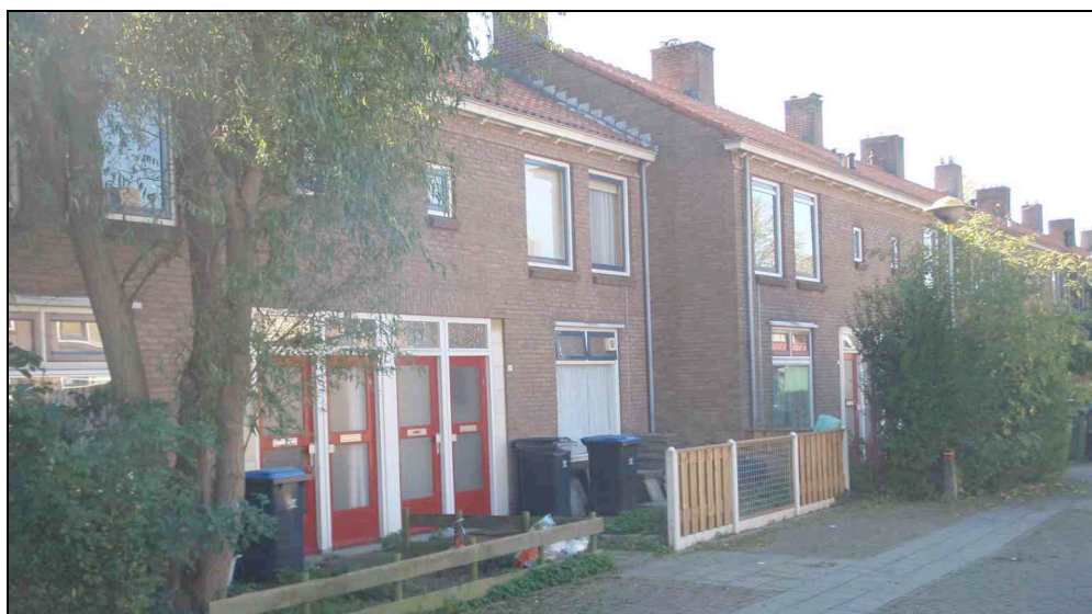
Figuur 5. Duplexwoningen aan de R. de Manstraat
