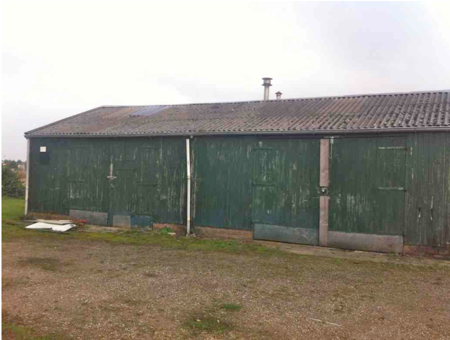
Foto 1 Eén van de twee te slopen schuren aan de Rietveldseweg 12 te Culemborg.
