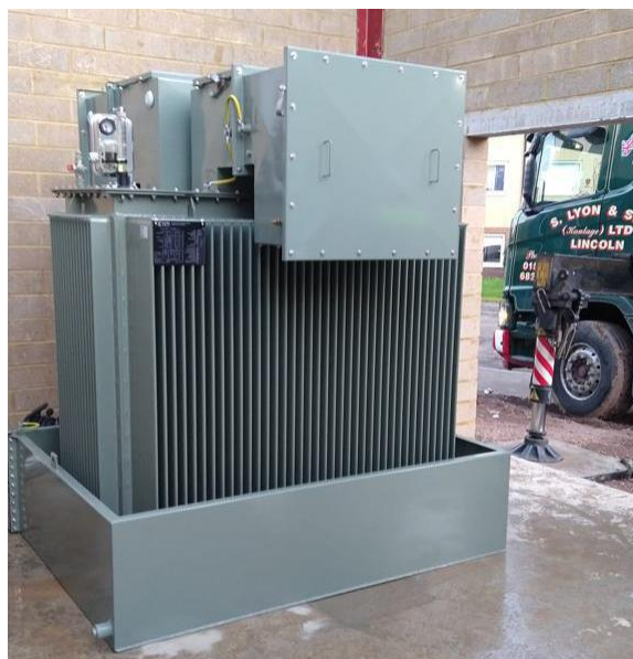
Figuur 16 - Voorbeeld van een MV-transformator van 2500 kVA met bundel en kabelkasten
