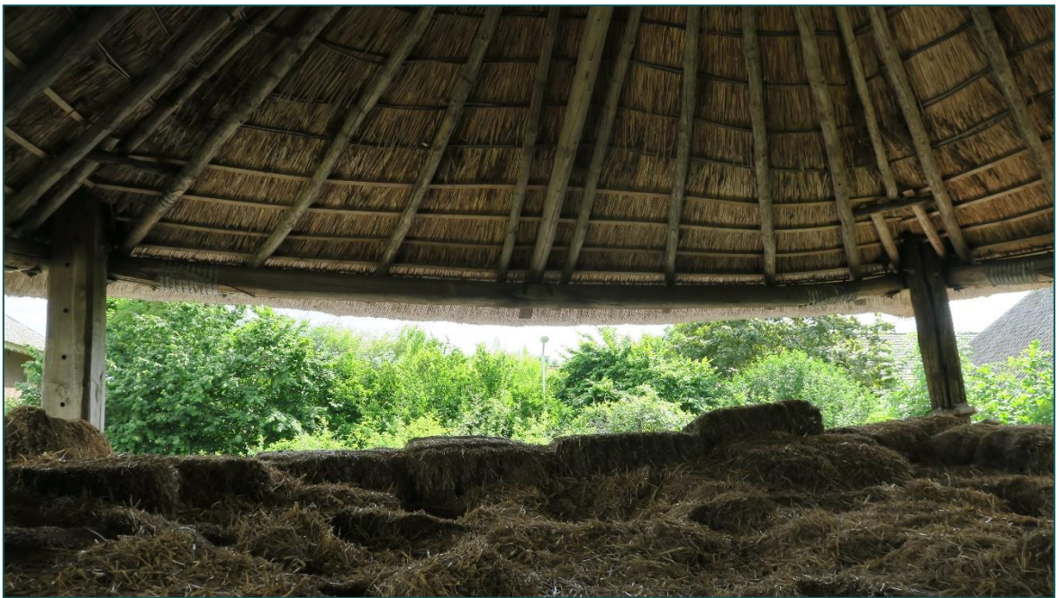
Figuur 4 De bovenverdieping van de hooiberg wordt gebruikt als hooiopslag. Het rieten dak is niet voorzien van dakbeschot.
