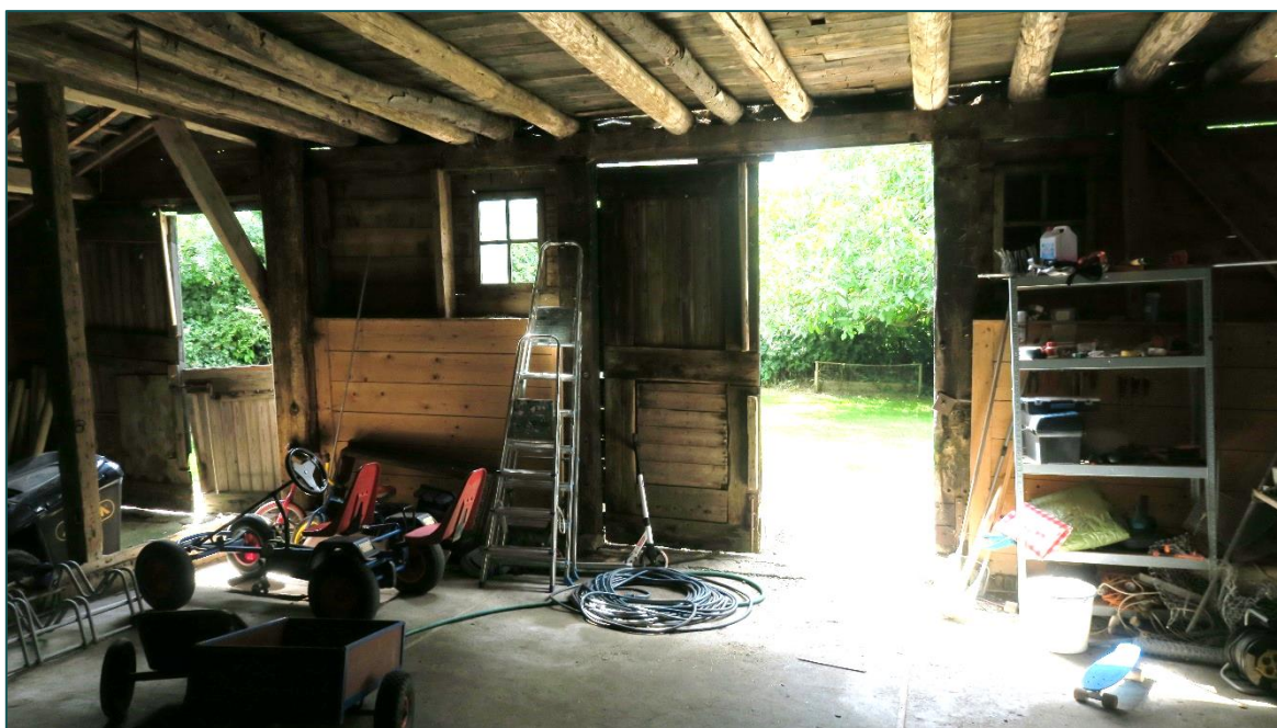
Figuur 2 De hooiberg is onder andere opgetrokken uit enkellaagse houten panelen. De foto weergeeft de binnenzijde van de hooiberg.
