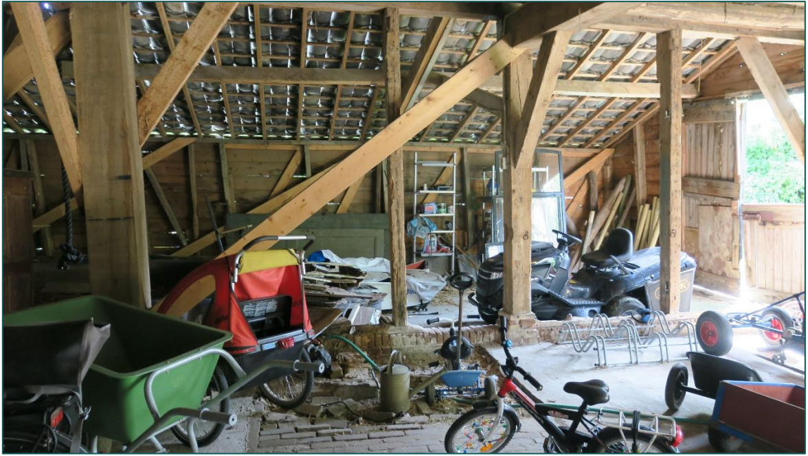
Figuur 3 De onderste verdieping van de hooiberg wordt gebruikt als opslagruimte. Het pannendak bevat geen dakbeschot.
