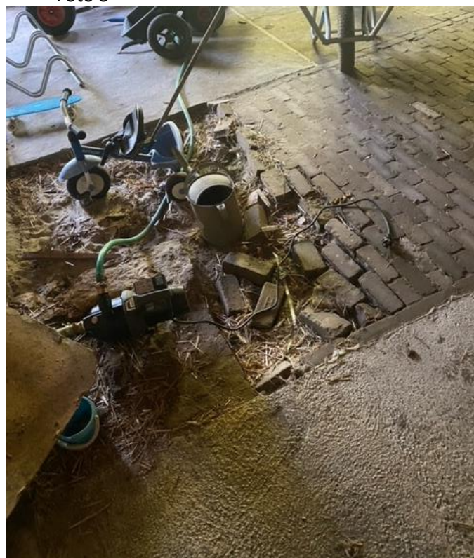
Foto 4. locatie vooraf boring 1
