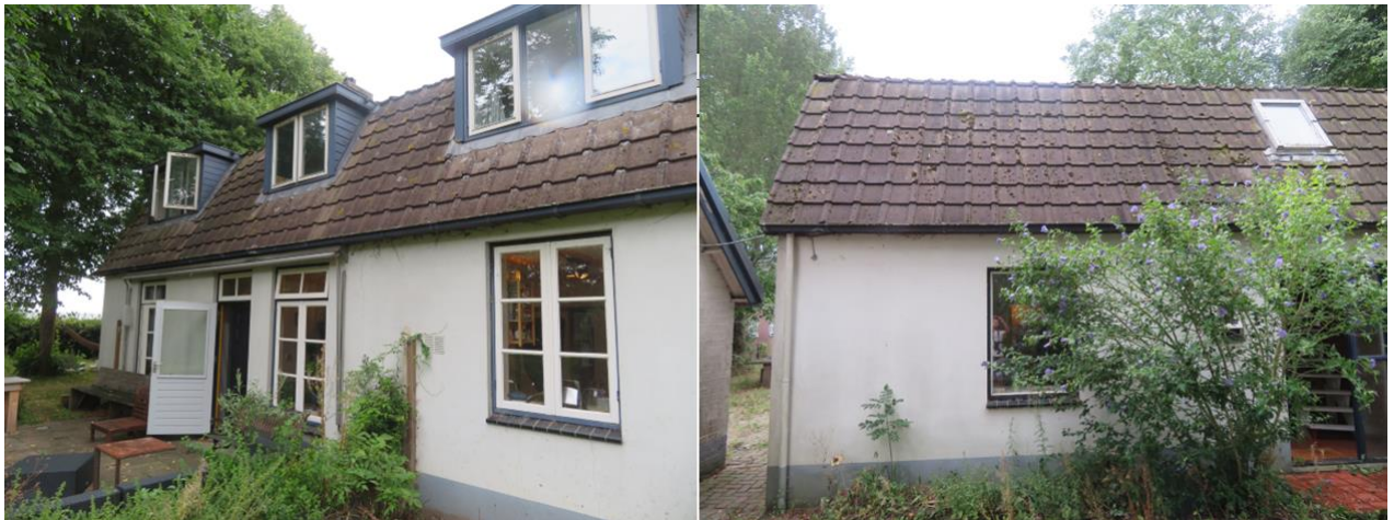
Afbeelding 4 en 5: Gebouw 1. Woning met gestucte muren. De betonnen dakpannen sluiten goed aan. De woning is in gebruik.
