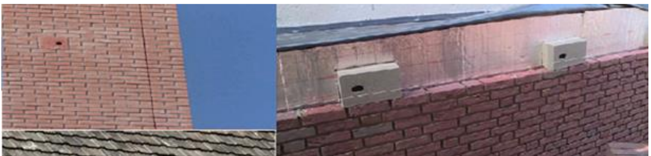
Vrijwel onzichtbare inbouw van vleermuisstenen en technische informatie over de plaatsing daarvan
