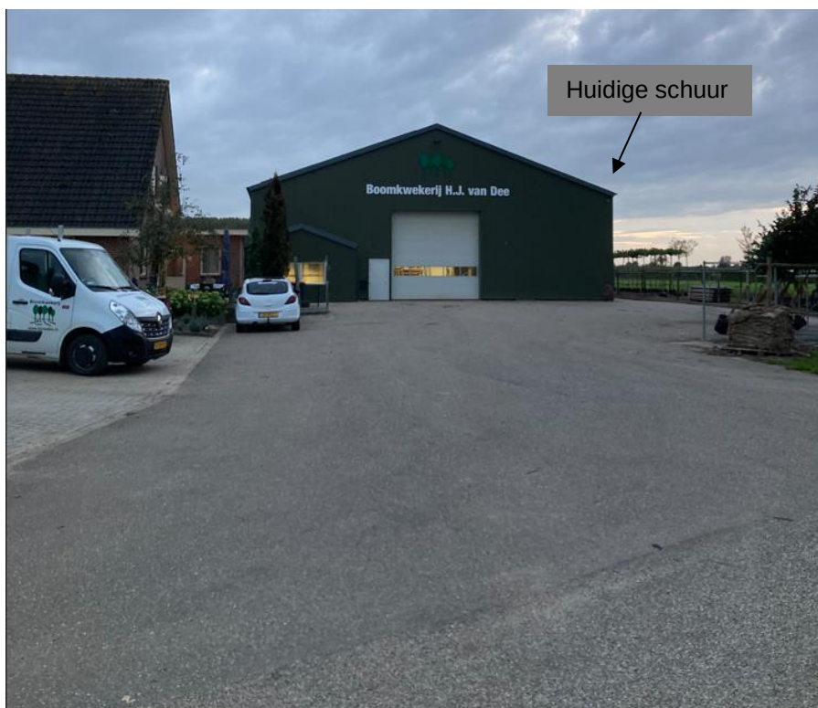
Figuur 5.3 - Bestaande dam welke gewenst is te gebruiken voor het transport van en naar de beoogde schuur.
