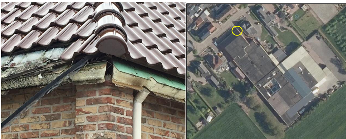
Foto links; openingen onder dakpannen kunnen dienen als nestlocatie voor huismussen. Luchtfoto recht: nestlocatie van huismussen.
