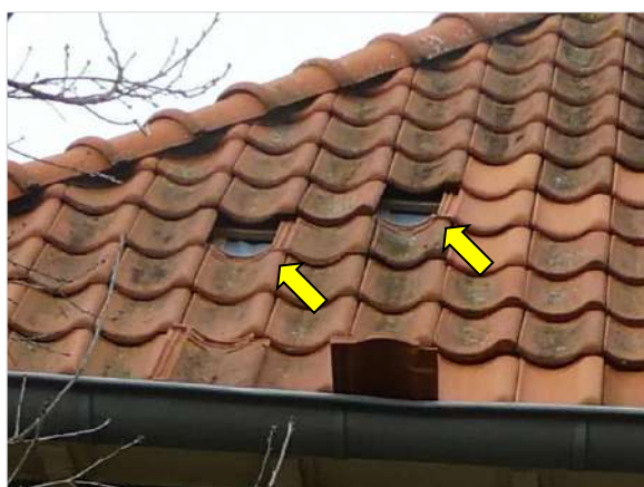
Figuur 4.8 Openingen onder de dakpannen die toegang verlenen tot ruimtes onder het dak.
