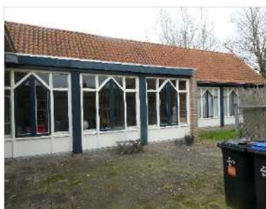
Figuur 2.4 Oostzijde onderzoekslocatie (2/2).
