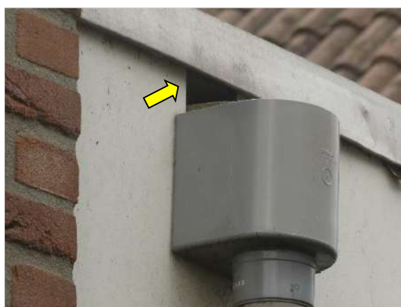
Figuur 4.2 Opening bij de regenpijp (bij gele pijl).
