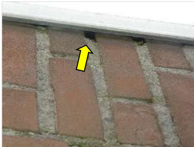
Figuur 4.4 Opening onder de daktrim welke toegang verleent tot de spouwmuur.
