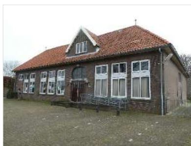
Figuur 2.3 Noordwestzijde gymzaal.
