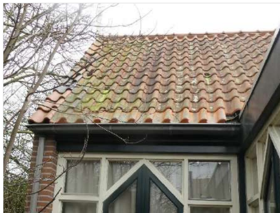
Figuur 4.2 Dakgoot welke toegang biedt tot ruimtes onder de dakpannen.
