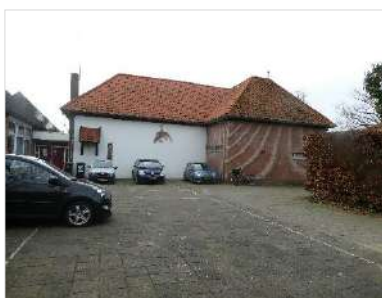
Figuur 2.4 Noordzijde gymzaal.
