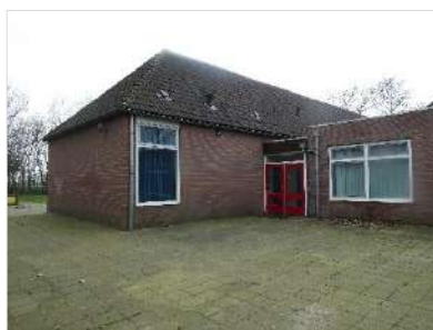
Figuur 2.6 Noordzijde schoolgebouw.
