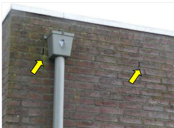
Figuur 4.6 Open stootvoegen die toegang verlenen tot de spouwmuur.
