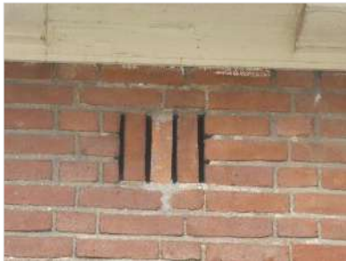
Figuur 4.3 Open stootvoegen die toegang verlenen tot de spouwmuur.
