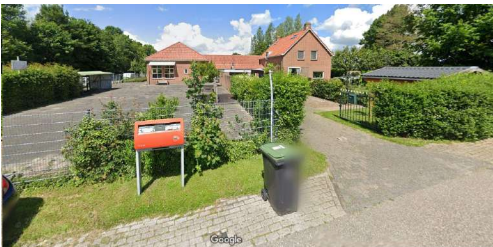
Figuur 2.2: De planlocatie Asch vanaf de Achterstraat met het schoolplein met fietsenhok en enkele speelfaciliteiten en het schoolgebouw in de achtergrond (Bron: Googlemaps).
