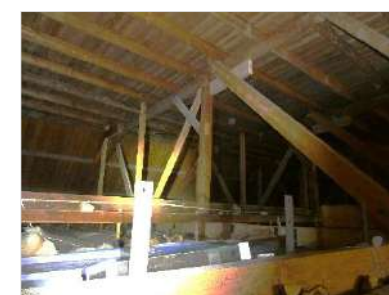
Figuur 2.14 Indruk van de zolder van de gymzaal.
