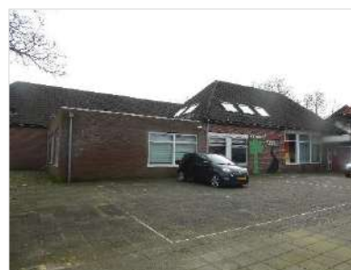
Figuur 2.5 Noordwestzijde schoolgebouw.
