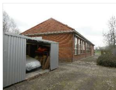
Figuur 2.8 Zuidwestzijde onderzoekslocatie.
