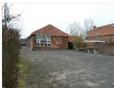
Figuur 2.3 Oostzijde onderzoekslocatie (1/2).
