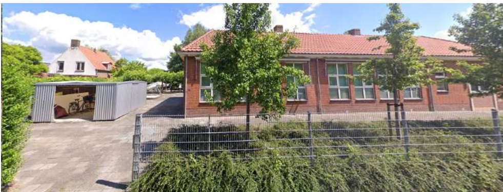
Figuur 2.1: De planlocatie Asch vanaf de Kerkstraat met het schoolgebouw (Bron: Googlemaps).
