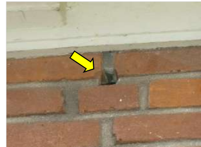
Figuur 4.5 Opening die toegang verleent tot de spouwmuur.
