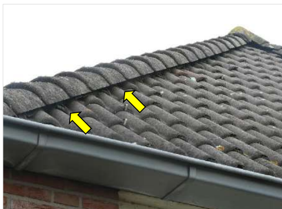
Figuur 4.7 Openingen onder de dakpannen die toegang verlenen tot ruimtes onder het dak.
