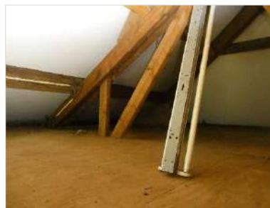
Figuur 2.11 Indruk zolderruimte.
