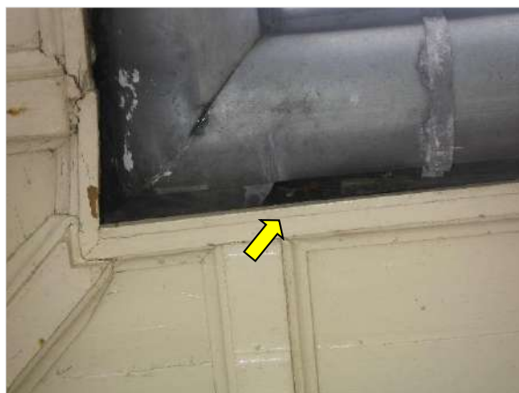
Figuur 4.4 Opening bij de dakgoot (bij gele pijl).
