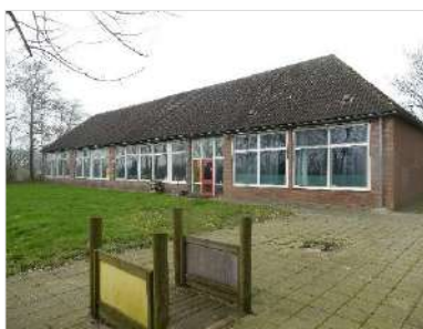
Figuur 2.7 Zuidoostzijde schoolgebouw.
