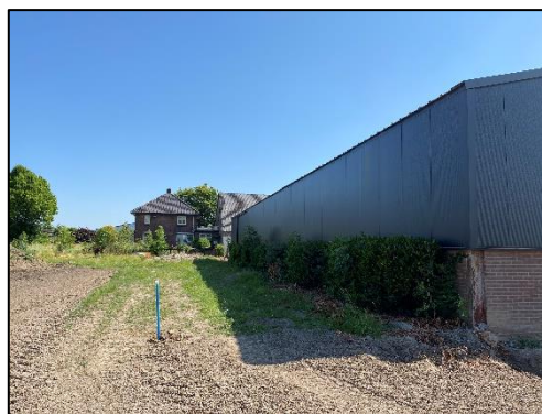
Overzichtsfoto gezien vanuit zuidwestelijke hoek van het perceel
