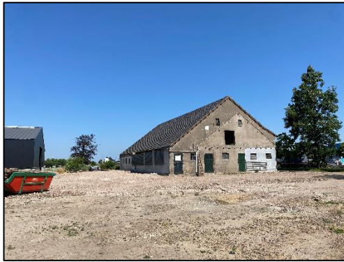
De kapschuur (rechts) en paardenschuur (links)
