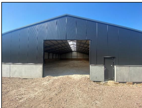
De paardenschuur gezien vanuit het noorden
