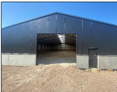
De paardenschuur gezien vanuit het noorden
