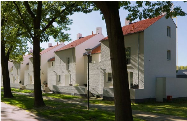
Wit gekeimd metselwerk zorgt voor textuur op het vlak. Kopgevels zijn mee-ontworpen in het geheel.
