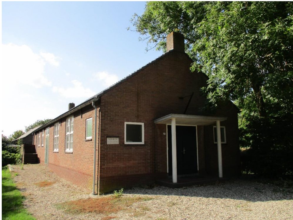
Figuur 1.2 De bebouwing op de planlocatie betreft een voormalig kerkgebouw en is opgetrokken uit gemetselde spouwmuren en een zadeldak met dakpannen.
