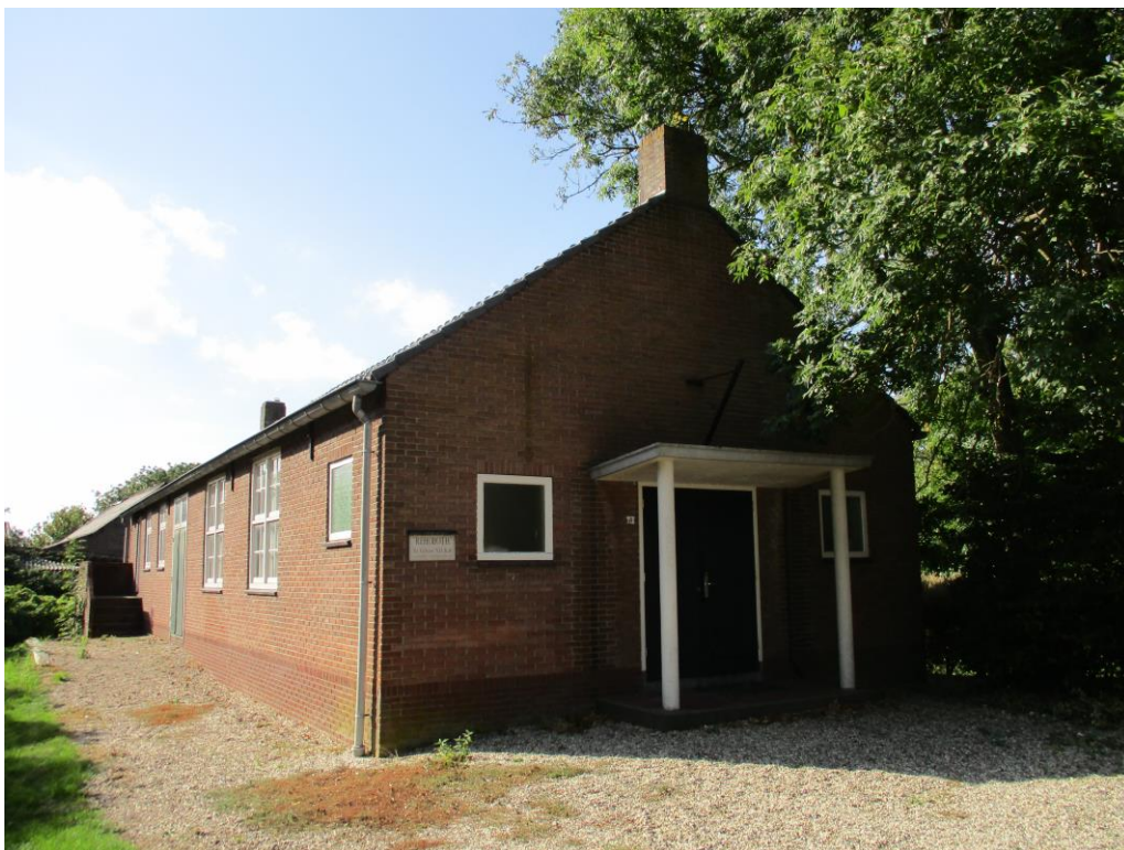
Figuur 1 De planlocatie is gelegen aan de Kerkstraat 4 te Rijswijk. Het betreft een voormalig kerkgebouw en is opgetrokken uit gemetselse steense spouwmuren en een zadeldak met dakpannen.
