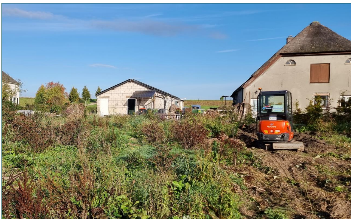
Figuur 4 Het perceel wordt als toegang tot Rijnbandijk 243 gebruikt door graafmachines.
