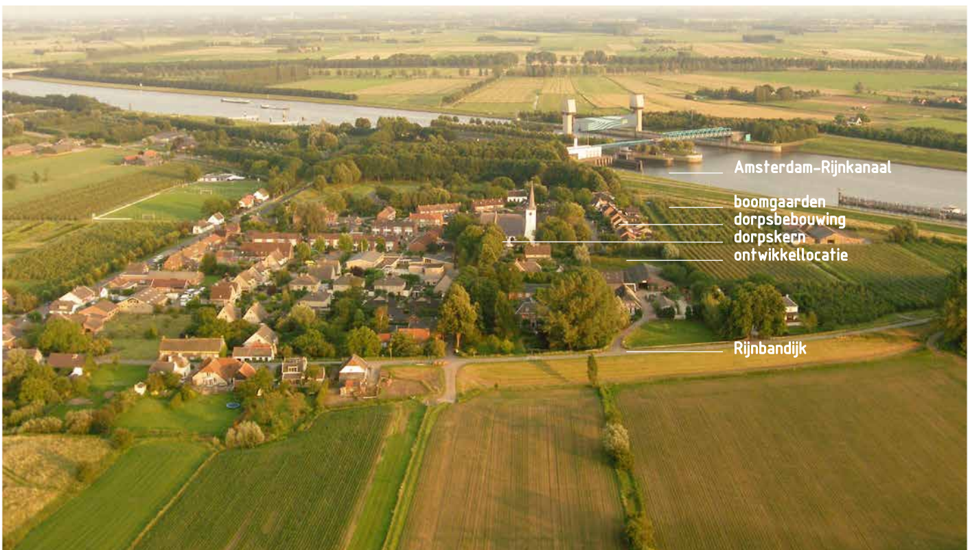
luchtfoto huidige situatie
