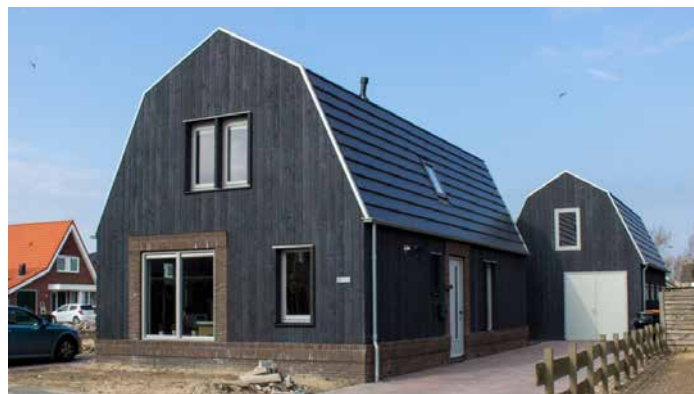
voorbeeld goede toepassing openingen in kopgevel
