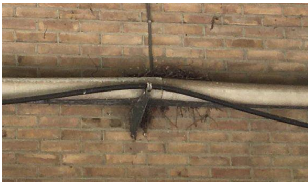
Aangetroffen oud nest van een houtduif onder de overkapping in het plangebied.
