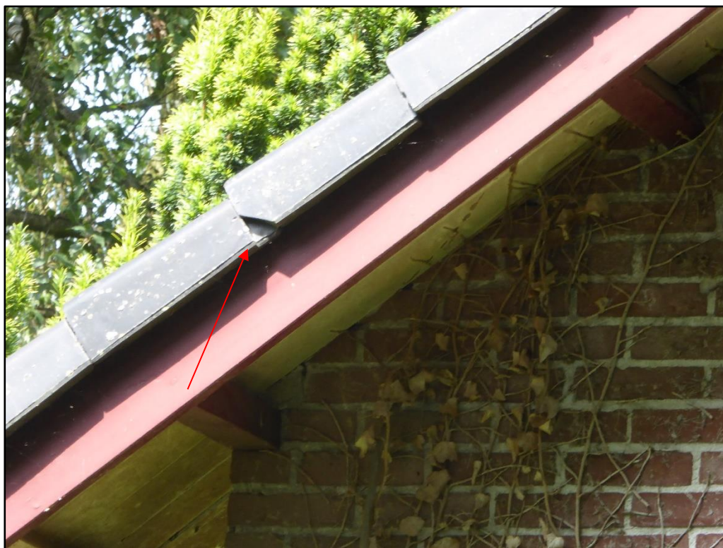
Het dak van de woning betreft een pannendak waaronder huismussen kunnen broeden.
