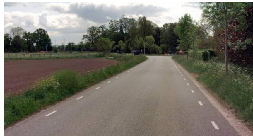
Figuur 7. Wegprofiel Mauriksestraat met kantstrook (bron: Cyclomedia).
