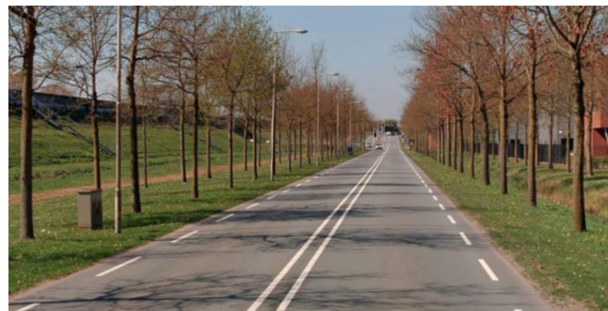
Figuur 4. Wegprofiel De Diepert met dubbele asmarkering en kantmarkering (bron: Cyclomedia).
