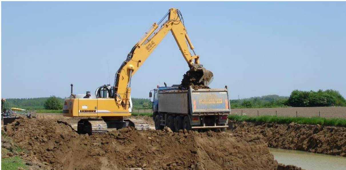
Figuur 12: Referentiebeeld kraan met dumper bij het ontgraven en toepassen van vrijkomende klei/bovengrond.
