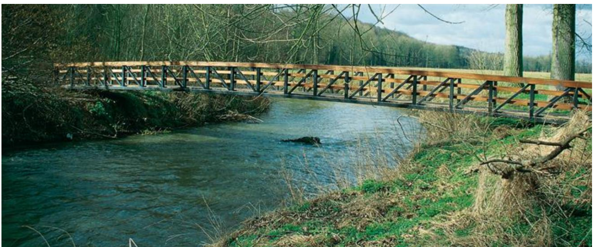
Figuur 11: De te plaatsen brug over de Linge (referentiebeeld).
