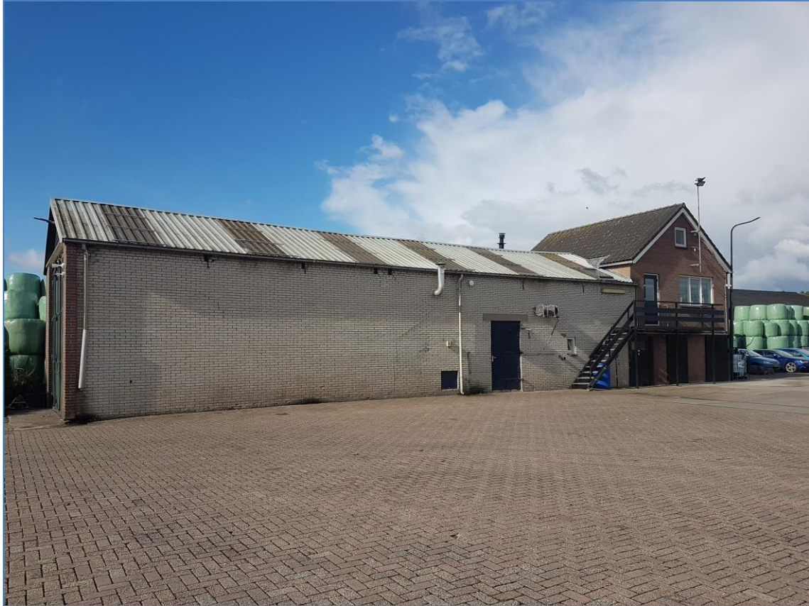
Figuur 2.5: Loods met kantoor
