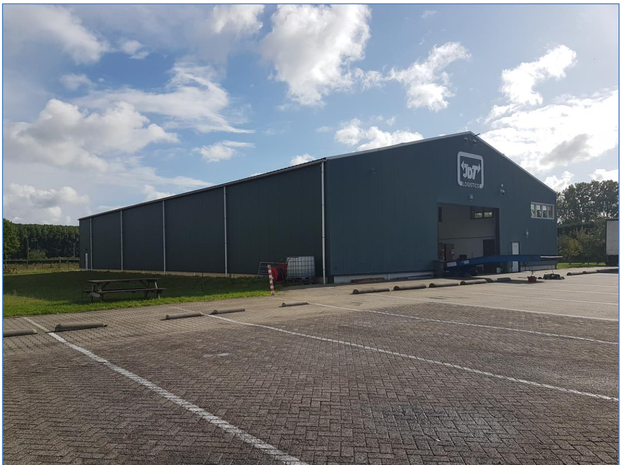
Figuur 2.4: Bestaande op- en overslag hal met kantoor en kantine
