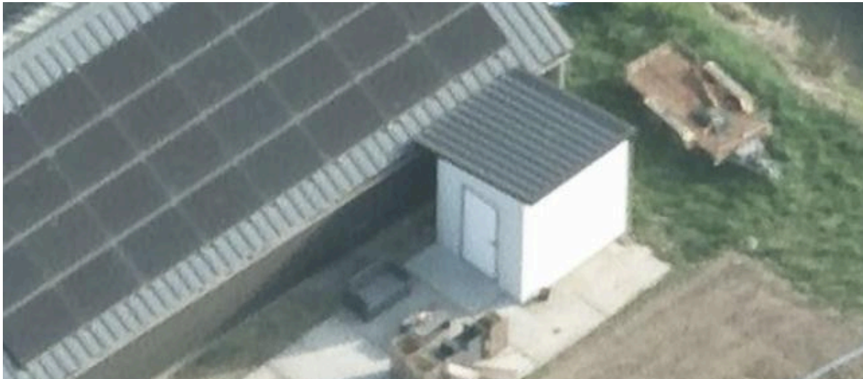
Te slopen bijgebouw
