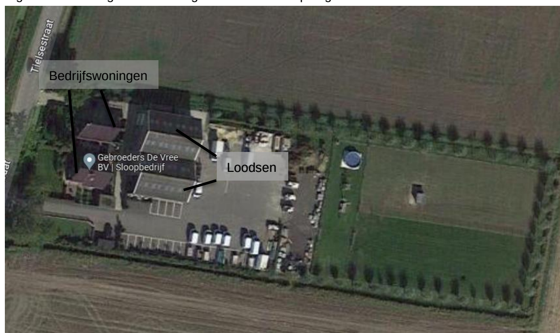
Figuur 2.2 - Huidige plangebied bestaande uit bedrijfswoningen (2x), loodsen (2x), verhard oppervlakte en groen.
