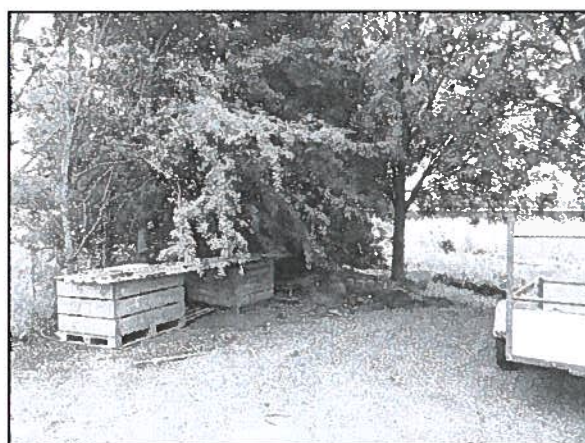
Foto 6: Vegetatie en materiaal langs sloot wordt verwijderd
