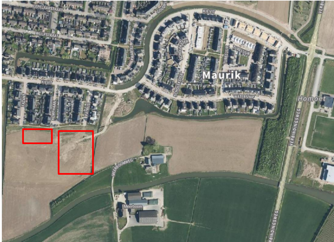
Luchtfoto bestaande situatie (2023)
