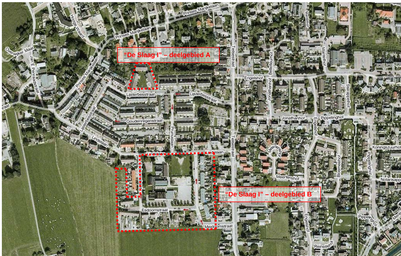
Luchtfoto ligging beide deelgebieden (bron: Google Maps)
