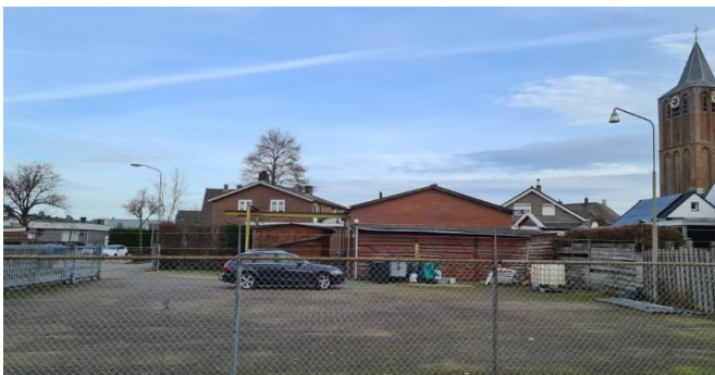
Figuur 4: Bebouwing vanaf zuiden
