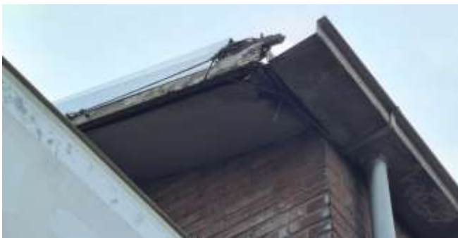
Figuur 7: Dakrand van woonhuis
