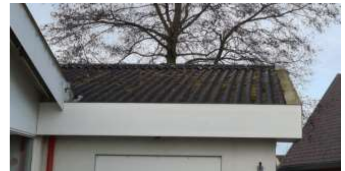
Figuur 6: Winkelpanden in het noorden van het plangebied, gezien vanaf de Waterstraat
