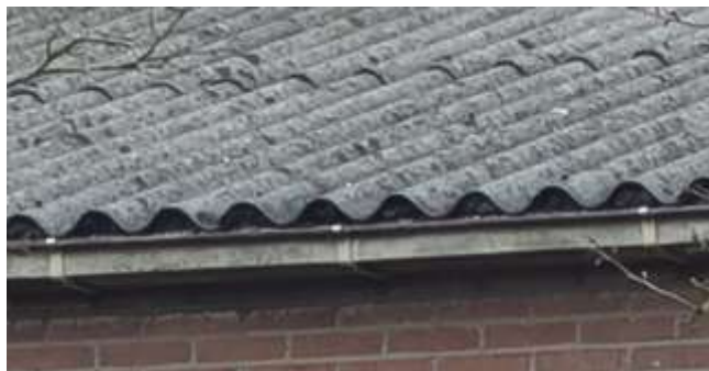
Figuur 8: Dakrand van woonhuis
