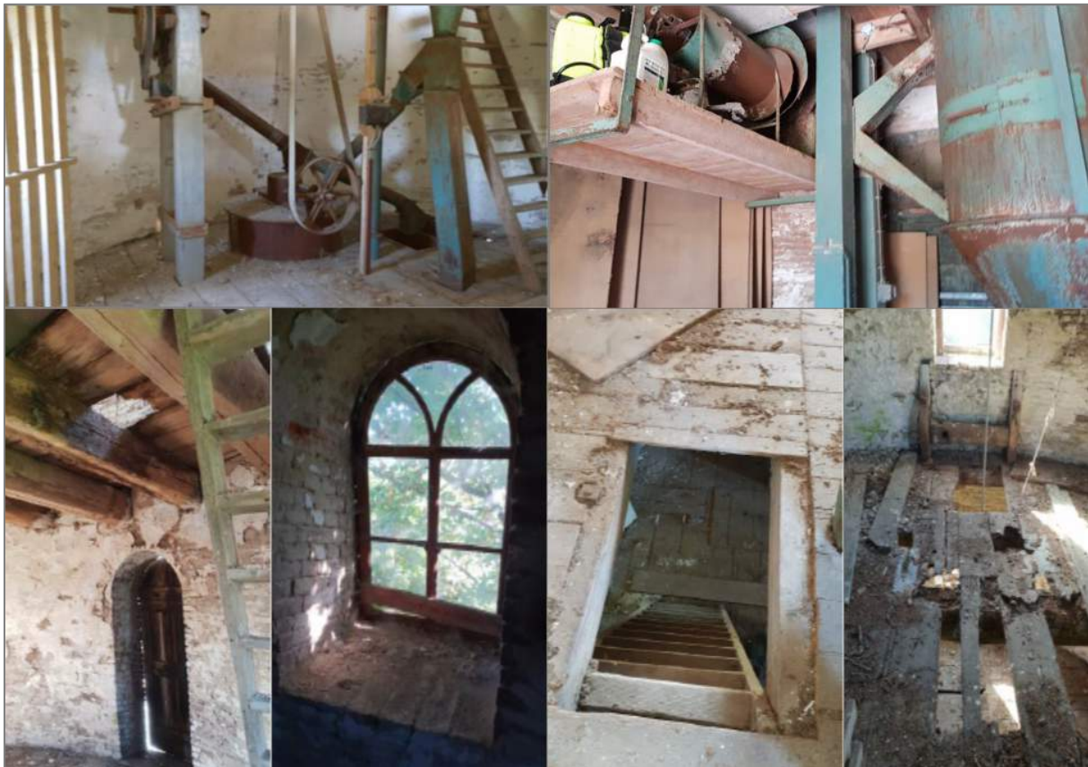
Figuur 2.5: Impressie huidige staat binnenkant van de monumentale molen.
