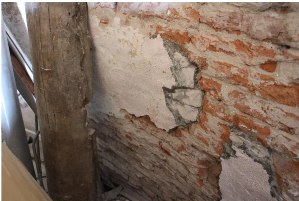
Zichtbare bouwsporen van het koppel mechanisch aangedreven molenstenen onderin de molen rechts. Geadviseerd wordt deze bouwsporen zichtbaar te houden.
