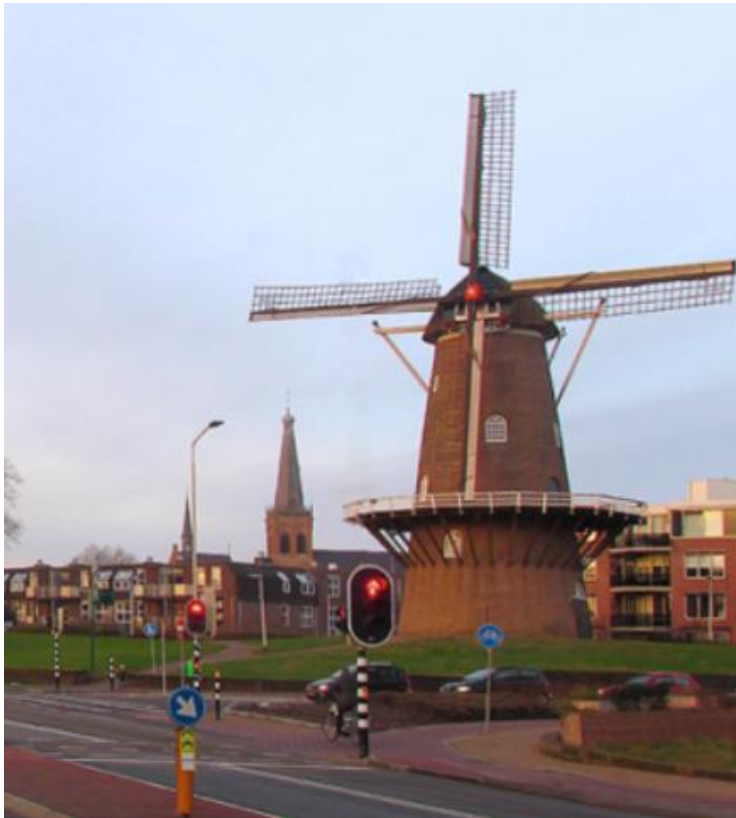
De Walmolen te Doetinchem. Deze molen kreeg het complete gangwerk met de bovenas van molen De Hoop te Lienden.
