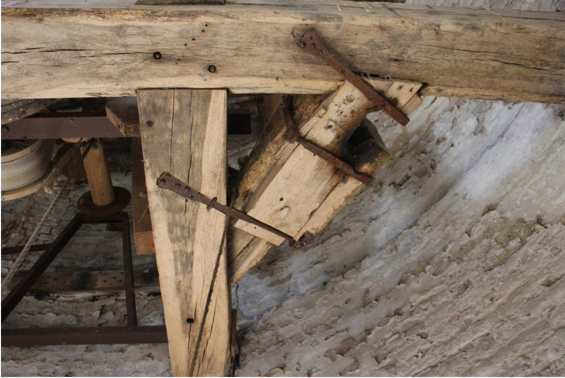
De bijzondere lagering van de steenspil van de maalstenen.
