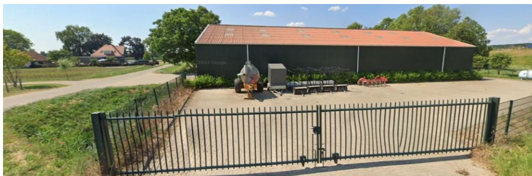
Bestaande situatie Marsdijk 26
