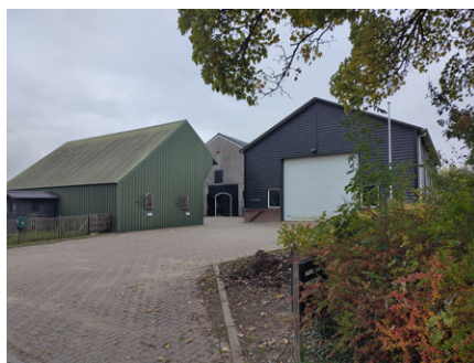
Bestaande (deels) te behouden boerderij aan Gildeland 24
