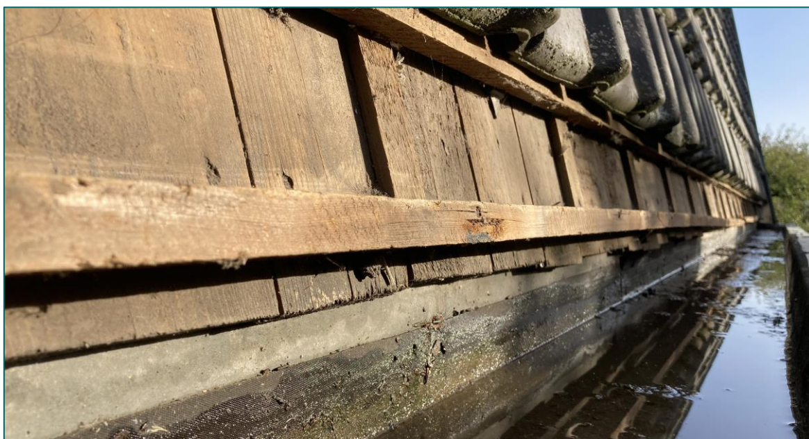
Figuur 3.4 Doordat de dakpannen strak op het dakbeschot liggen en er een horizontale panlat aan de onderzijde van de dakpannen aanwezig is, kunnen huismussen niet onder de dakpannen komen (afbeelding aangeleverd door S. Barten op 26 oktober 2023).
