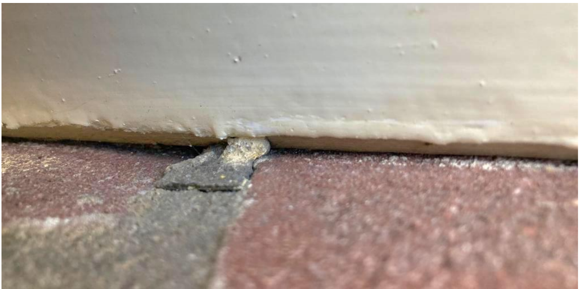
Figuur 3.2 Het boeiboord sluit volledig aan op de gevel, waardoor er geen sprake is van openingen waardoor vleermuizen de bebouwing kunnen betreden (afbeelding aangeleverd door S. Barten op 31 oktober 2023).
